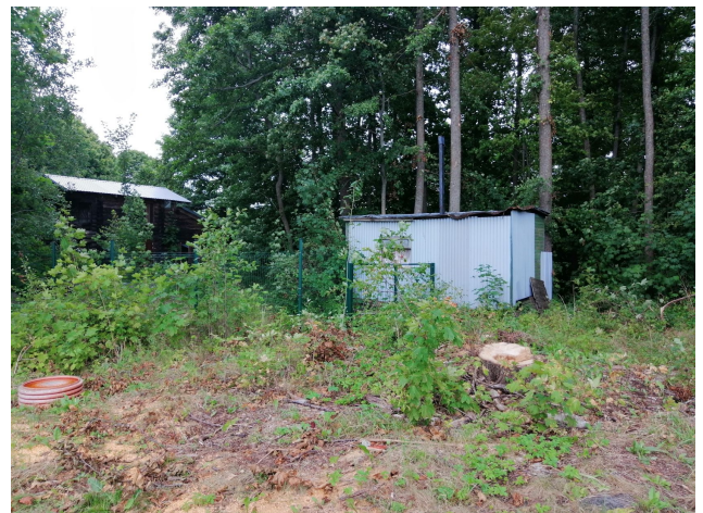
Foto 6: Vaade kinnistu kirdenurka ehitatud naabri kuurile
