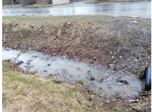
Foto 12. Sademeveetoru suubumine kraavi (kp 12.04.2021.a)
