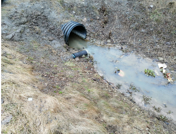
Foto 11. Sademeveetoru suubumine kraavi (kp 12.04.2021. a)
