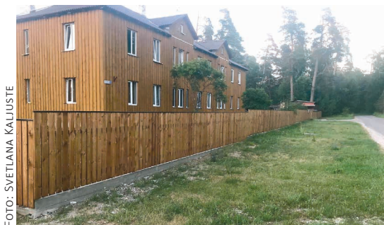
Metsa tn 22, Klooga tänavapoolse puitlippaia ja väravate renoveerimine.
