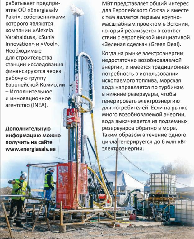
Геология Палдиски способствует строительству, которое не наносит ущерба окружающей среде. На фото: агрегат ЗВО для глубокого бурения.
