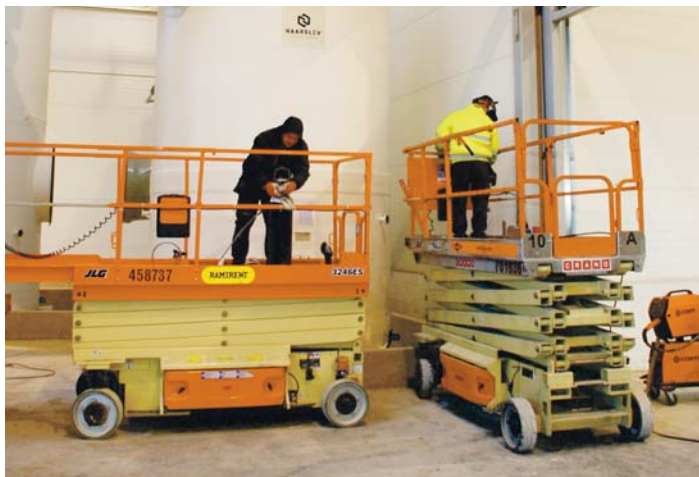
В цехе по переработке рыбы идет монтаж оборудования.
