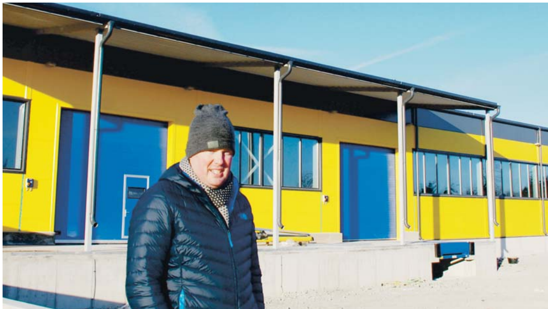
Март Ундрест говорит, что площадь нового производственного здания составляет более 4500 кв. м. Построила завод фирма Bauest OÜ, работать здесь будет 25 человек.
