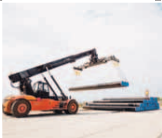
Первые трубы для газопровода в порту г. Палдиски. Фото: АО Элеринг
