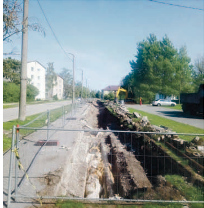
Uute soojatrasside paigaldamine Paldiskis.
