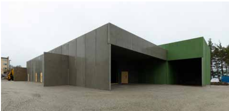
Kaitseväe Paldiski linnaku toitlustuskompleks
