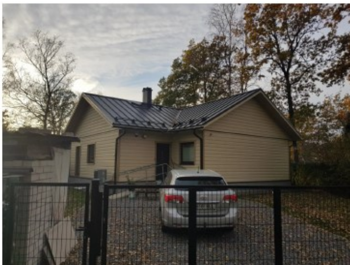
Foto 11: Vaade Tamme tn 4 kinnistule Terase Üldmaa 4 poolt
