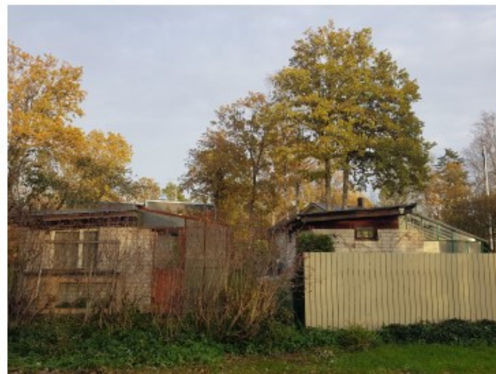
Foto 12: Vaade Tamme tn 6 ja Tamme tn 4 abihoonetele, mille vahele on planeeringuga ette nähtud tulemüür.
