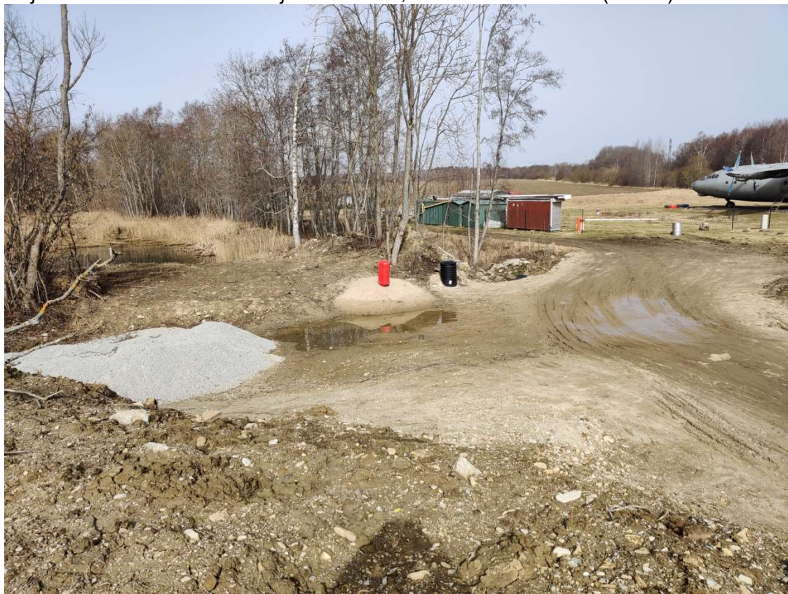
Foto 1 Väljaotsa tee L1 teemaal asuvad tuletõrjeveesüsteemid, mis kuuluvad AS-ile Valdek
