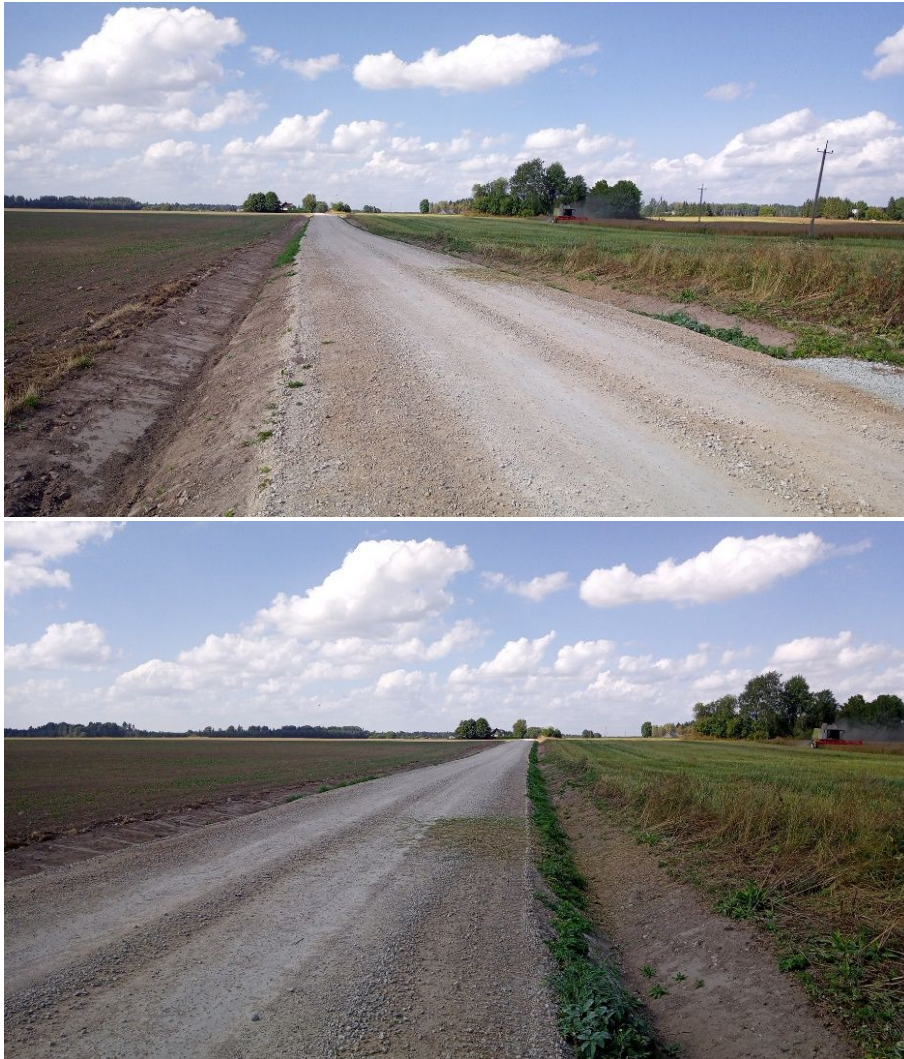
Joonis 11.3. Riigimaanteel taastatud kraavid (näited)
