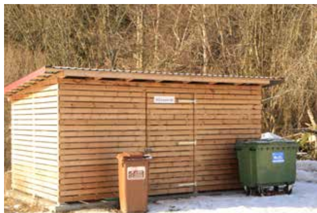
Навес для мусорных контейнеров ФОТО ИЗ ЧАСТНОЙ КОЛЛЕКЦИИ
